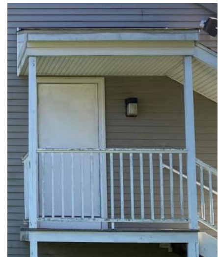
2 nd Floor egress door
