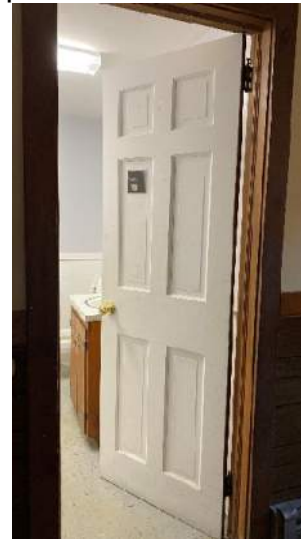
Toilet room interior door
