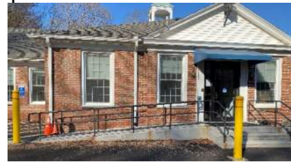
ADA accessible ramp
